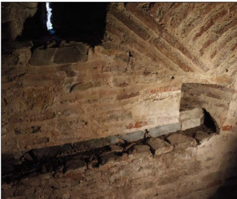
Φωτ.61 Ίχνος εντός της Β τοικοποιΐας της προ του Υπερώου διόδου, προϋπάρχουσας ευμεγέθους μάντωσης, που έχει εντελώς αποσυντεθεί.
