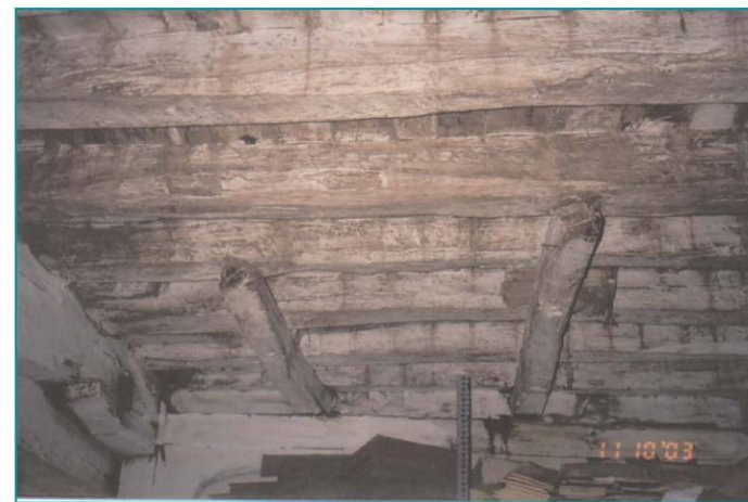
ΕΙΚ.6,7 Παραδείγματα του τυπικού βοηθητικού τρόπου στήριξης των ξυλόπηκτων τοίχων των ορόφων, των παράλληλων προς τις δοκούς του πατώματος, σε βραχείς προβόλους που αντιστηρίζονται στις δοκούς του πατώματος αυτού.
