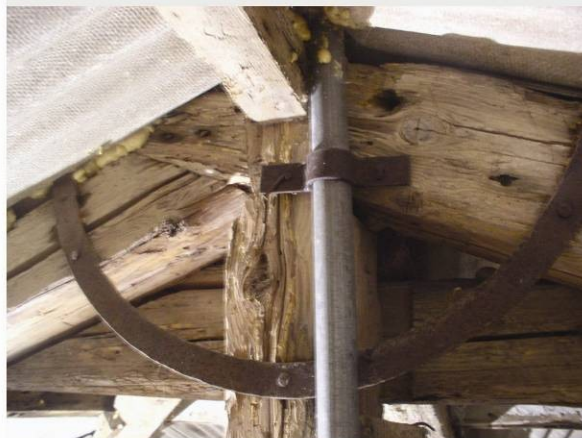
ΣΥΜΠΛΗΡΩΣΗ ΤΗΣ ΓΩΝΙΑΣ ΤΟΥ ΑΜΕΙΒΟΝΤΑ ΜΕ ΞΥΛΙΝΗ ΣΦΗΝΑ
