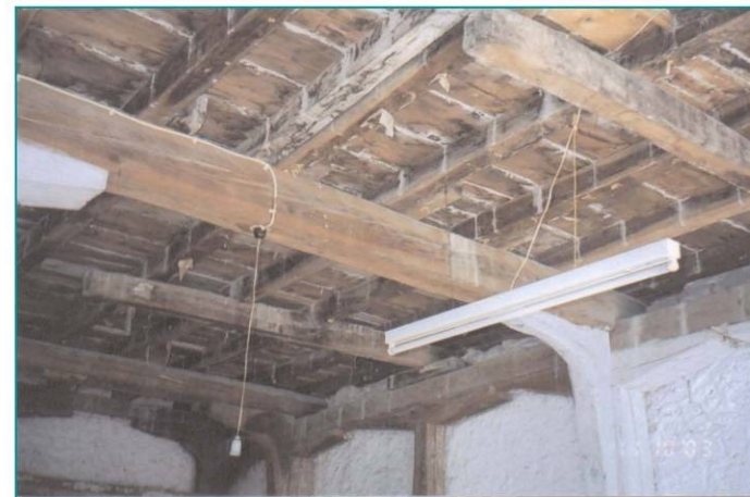
ΕΙΚ.6,7 Παραδείγματα του τυπικού βοηθητικού τρόπου στήριξης των ξυλόπηκτων τοίχων των ορόφων, των παράλληλων προς τις δοκούς του πατώματος, σε βραχείς προβόλους που αντιστηρίζονται στις δοκούς του πατώματος αυτού.
