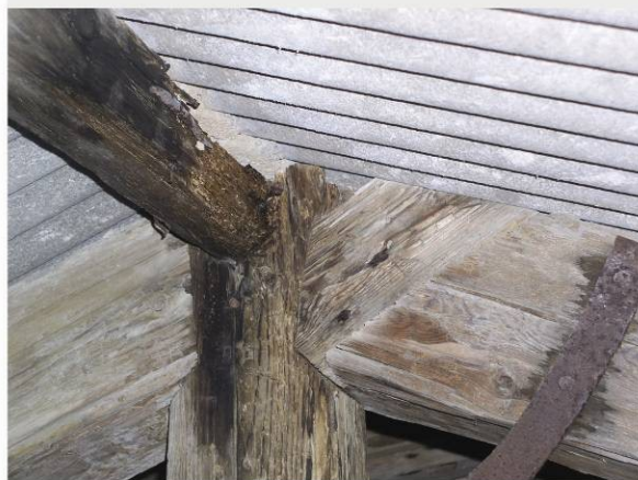
ΣΥΜΠΛΗΡΩΣΗ ΤΗΣ ΓΩΝΙΑΣ ΤΟΥ ΑΜΕΙΒΟΝΤΑ ΜΕ ΞΥΛΙΝΗ ΣΦΗΝΑ
