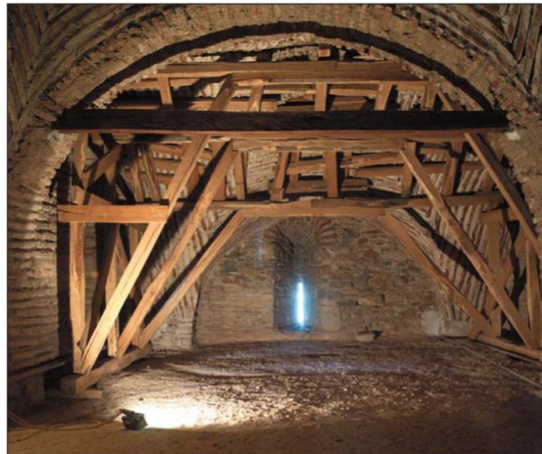
Φωτ.62 Πρόχειρη υποστήλωση της ρηγματωμένης θολοδομίας γωνιακού χώρου του Υπερώου.
