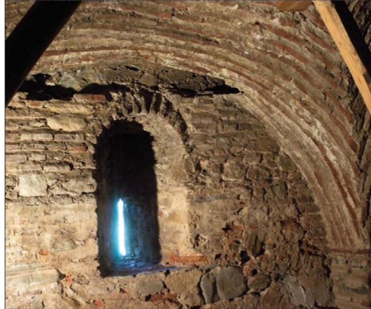
Φωτ.60 Ίχνος εντός της τοικοποιΐας προϋπάρχουσας ξύλινης περιμετρικής μάντωσης, που έχει αποσαρθρωθεί.
