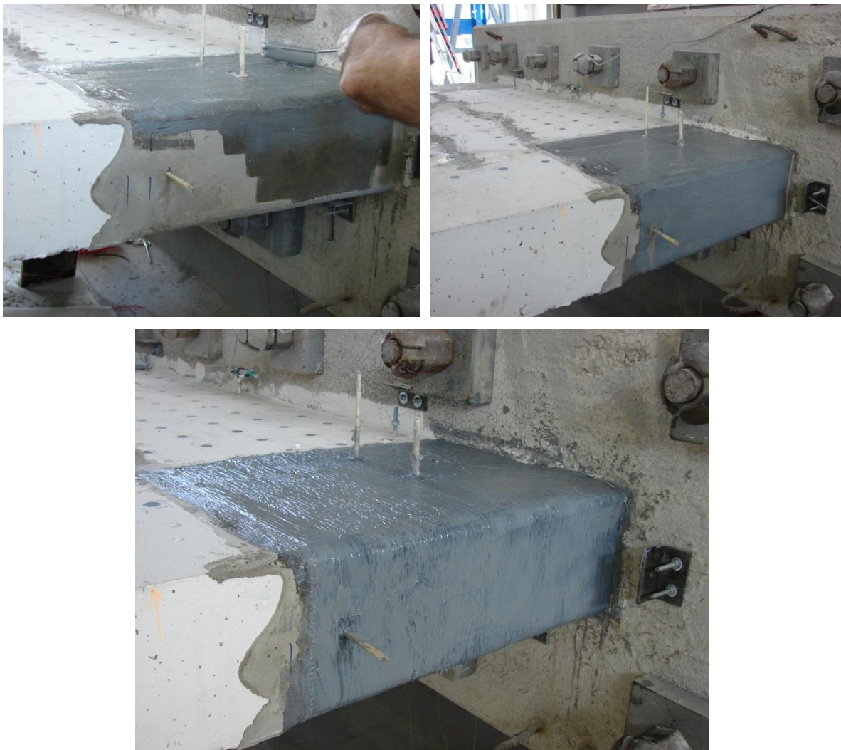
Σχήμα 100: Τοποθέτηση μανδύα ινοπλισμένων πολυμερών
