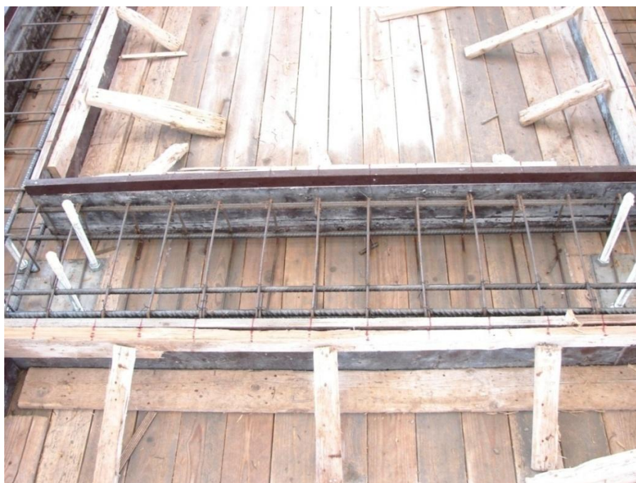
Σχήμα 53: Όπλιση δοκού
