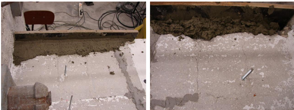
Σχήμα 96: Αποκατάσταση σκυροδέματος υποστλωμάτων με επισκευαστικό κονίαμα
