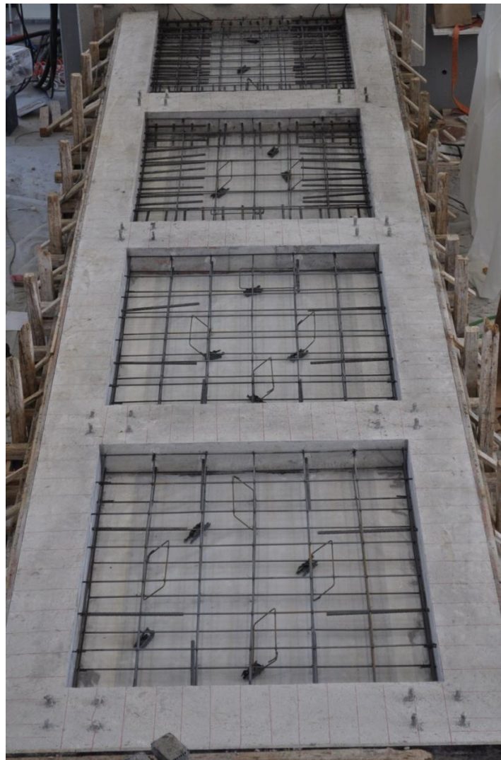
Σχήμα 146: Οπλισμός φατνωμάτων
