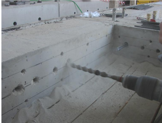
Σχήμα 55: Διάνοιξη οπών
