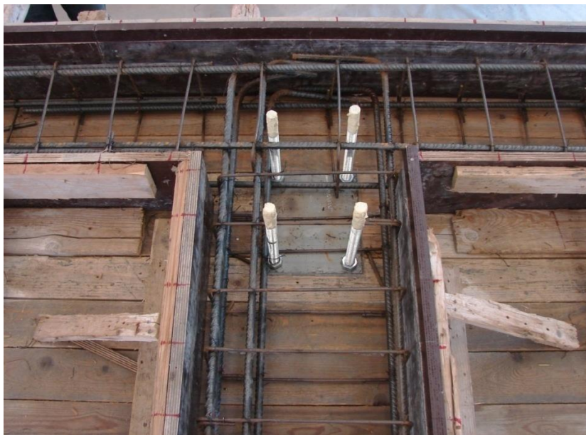
Σχήμα 51: Όπλιση πλαισίου, κόμβος υποστυλώματος – δοκού
