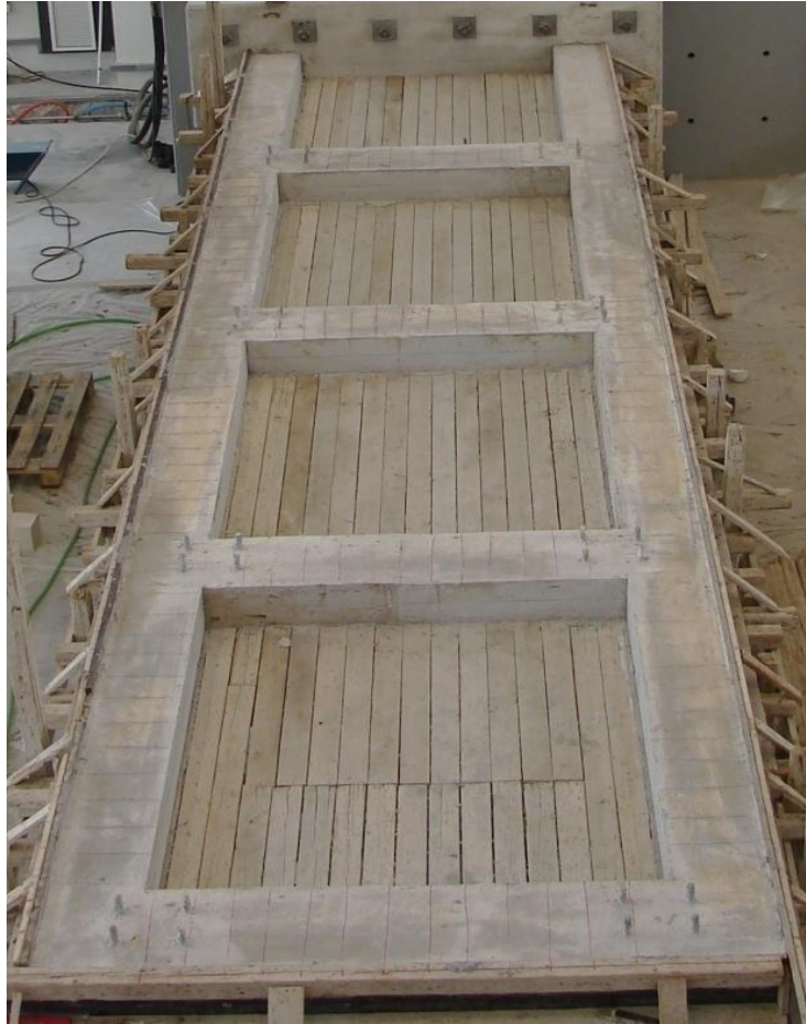
Σχήμα 54: Σκυροδετημένο πλαίσιο πριν την εμφότνωση
