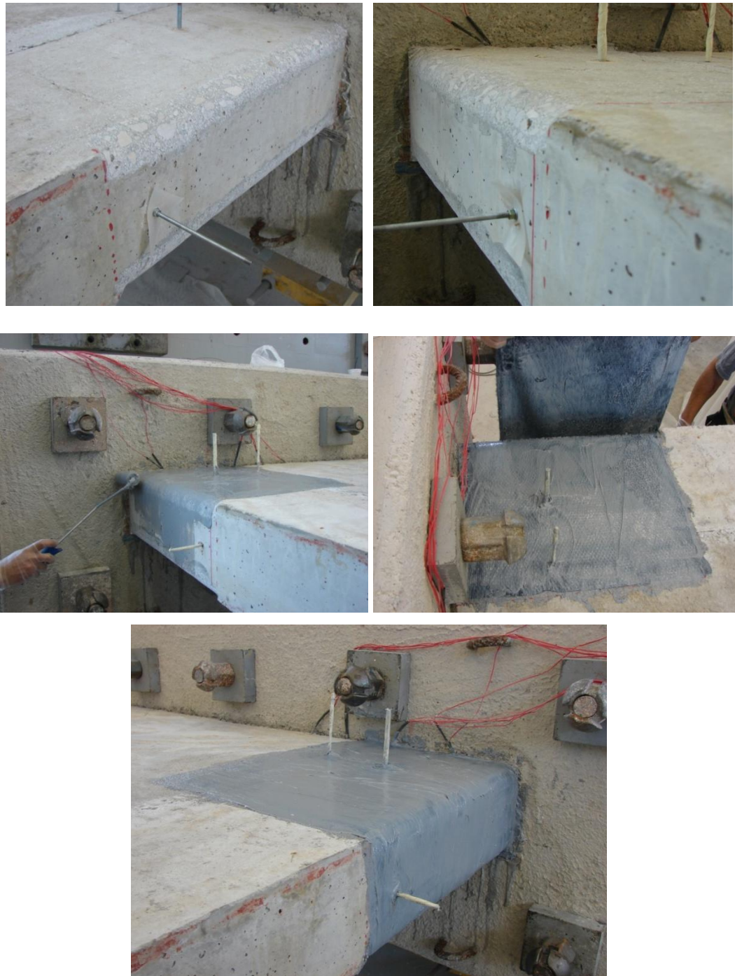
Σχήμα 154: Τοποθέτηση μανδύα ινοπλισμένων πολυμερών
