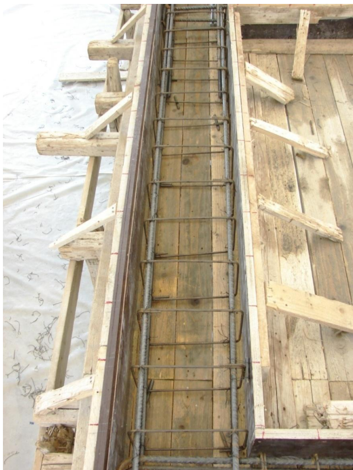
Σχήμα 52: Όπλιση υποστύλωσης
