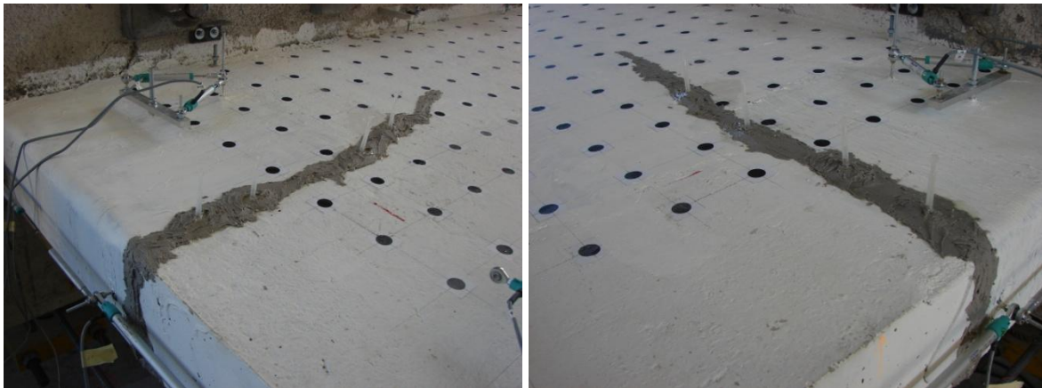
Σχήμα 126: Σφράγιση ρωγμών με εποξειδική πάστα, τοποθέτηση ακροφυσίων
