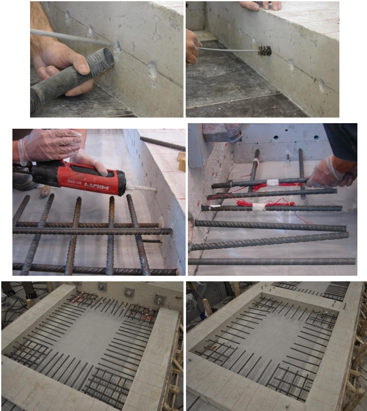
Σχήμα 144: Διαδικασία τοποθέτησης βλήτρων 1ου ορόφου (αριστερά), 2ου ορόφου (δεξιά)
