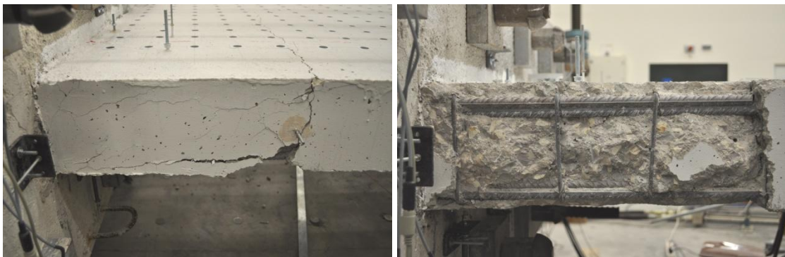
Σχήμα 82: Λεπτομέρειες ρηγμάτωσης υποστυλώματος βόρειας πλευράς στο τέλος της δοκιμής
