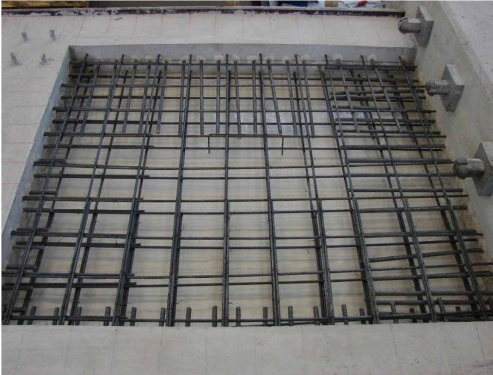
Σχήμα 60: Οπλισμός 1ου ορόφου
