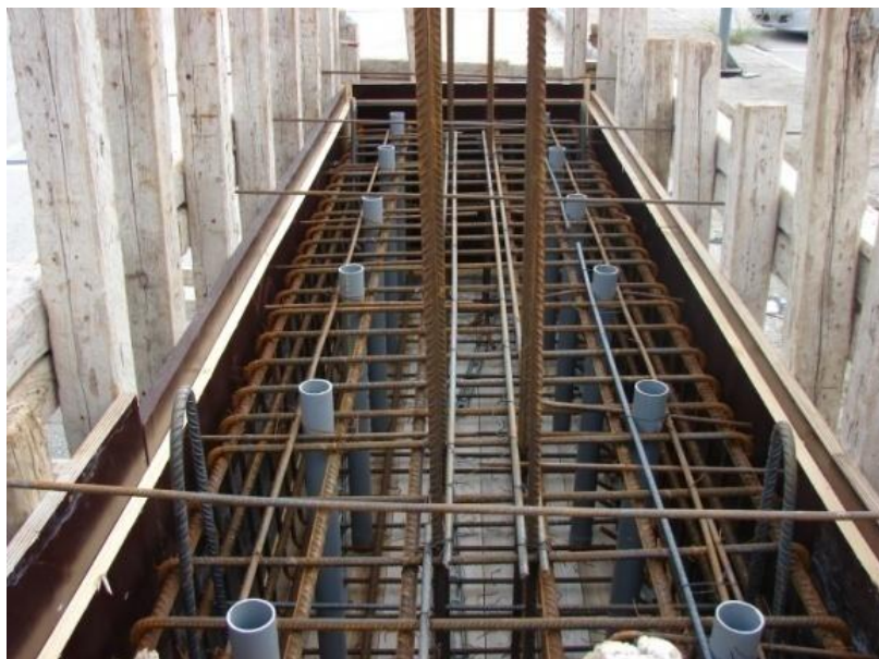
Σχήμα 46: Οπλισμός βάσης τοιχώματος
