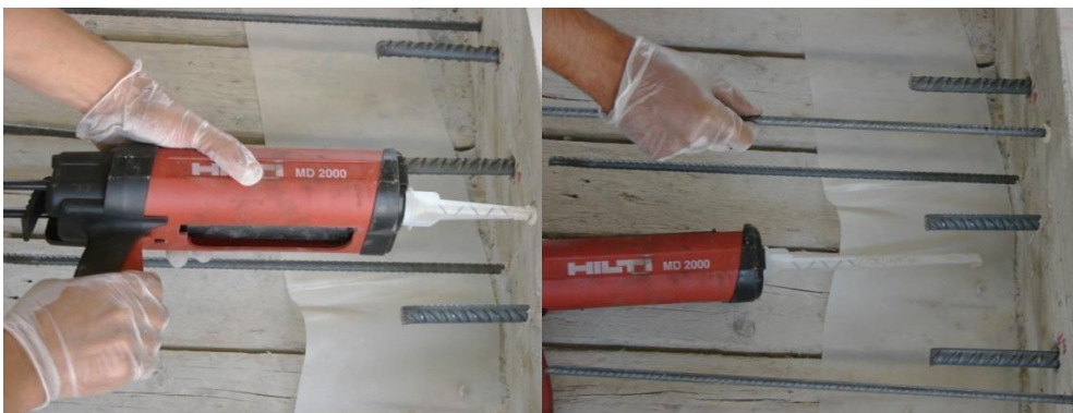
Σχήμα 57: Έγχυση ρητίνης και τοποθέτηση βλήτρων και αγκυρίων
