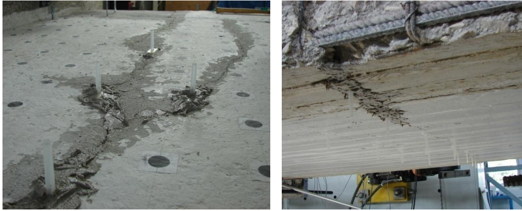
Σχήμα 97: Τοποθέτηση ακροφυσίων κατά μήκος της ρωγμής
