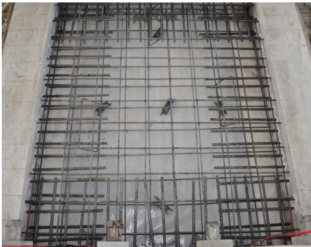
Σχήμα 147: Οπλισμός 1ου ορόφου
