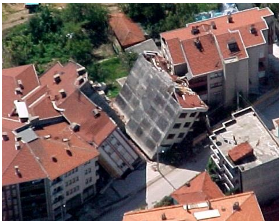
Σχήμα 1.1: Αστοχία επιφανειακής θεμελιώσης λόγω ρευστοποίησης στο σεισμό του Adapazari - Τουρκία (1999)
