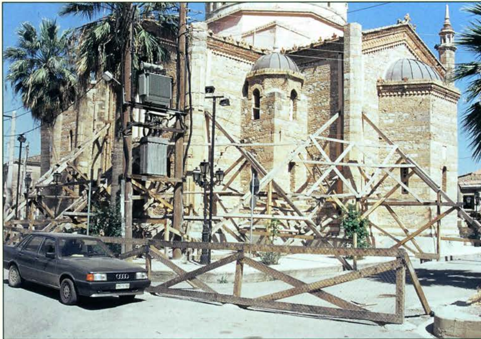
ΑΙΓΙΟ 1995 Εκτεταμένη αντιστήριξη με βιομηχανική ξυλεία στο Ναό Εισοδίων της Θεοτόκου - Έργο Ταϊλλερ, - ο οποίος υπέστη σοβαρές βλάβες.
