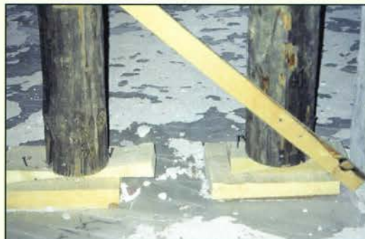
Λεπτομέρειες αφηνώσεων σε υποστυλώσεις με κορμούς δένδρων.
