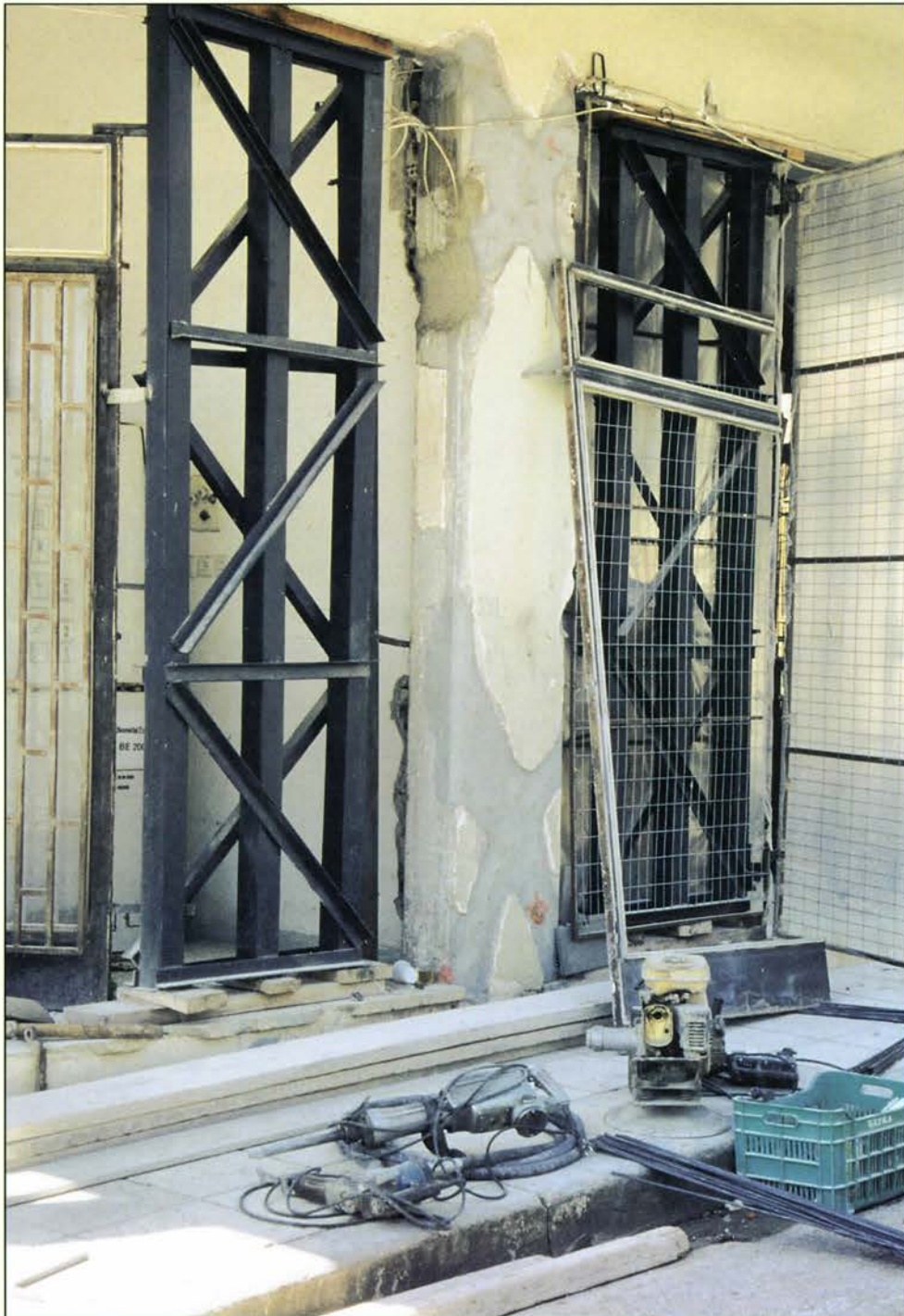
ΑΙΓΙΟ 1995 Υποστήλωση με τετράγωνες κοιλοδοκούς εκατέρωθεν βλαμμένου υποστυλώματος. Η μέθοδος αυτή υποστήλωσης είχε ευρεία εφαρμογή στο Αίγιο.
