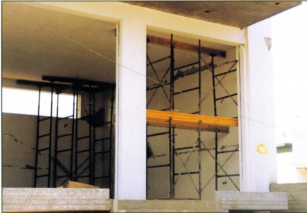
ΑΤΤΙΚΗ - ΜΕΝΙΔΙ- 1999 Μερική υποστήλωση με μεταλλικά βιομηχανικά ικριώματα σε μαλακό όροφο με ελαφρές βλάβες.
