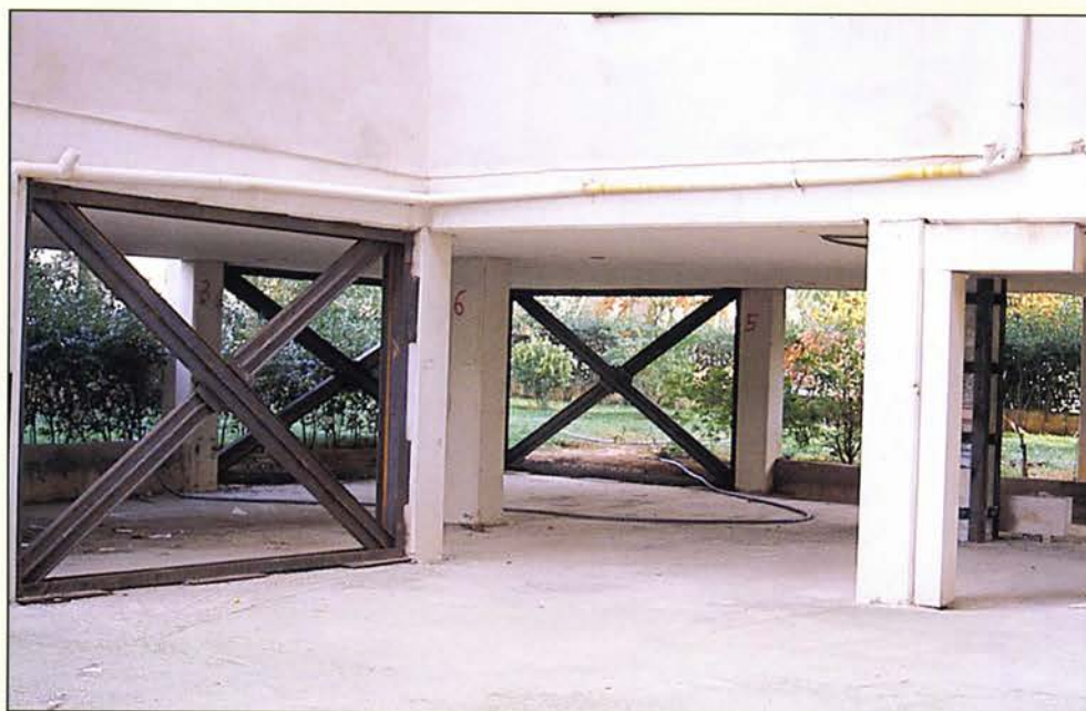
ΜΕΤΑΜΟΡΦΩΣΗ ΑΤΤΙΚΗΣ 1995 Εκτεταμένη υποστήλωση με σιδηρές διατομές (γωνιακά ισχυρά, διπλά ταύ, λάμες, χιαστί συνδέσμους κ.λπ.) σε τετραόροφη οικοδομή με σοβαρές βλάβες στα υποστυλώματα της Pilotis
