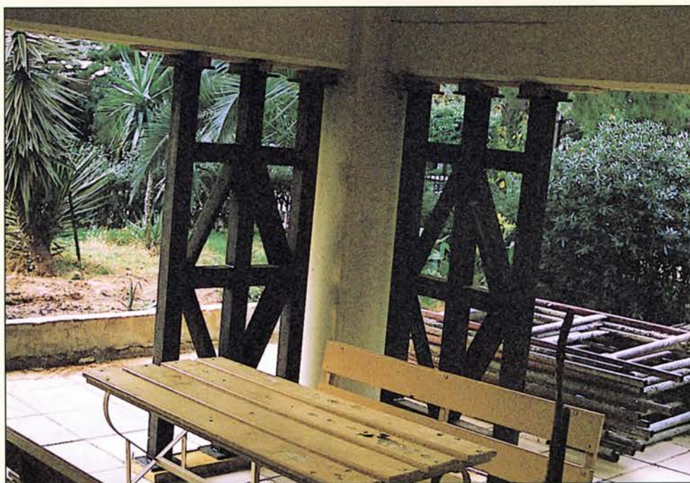
ΑΤΤΙΚΗ - ΝΕΟ ΗΡΑΚΛΕΙΟ - 1999 Εκτεταμένη υποστυλώση με κοιλοδοκούς σε Pilotis εξαώροφης οικοδομής, με σοβαρές βλάβες σε αρκετά από τα υποστυλώματά της
