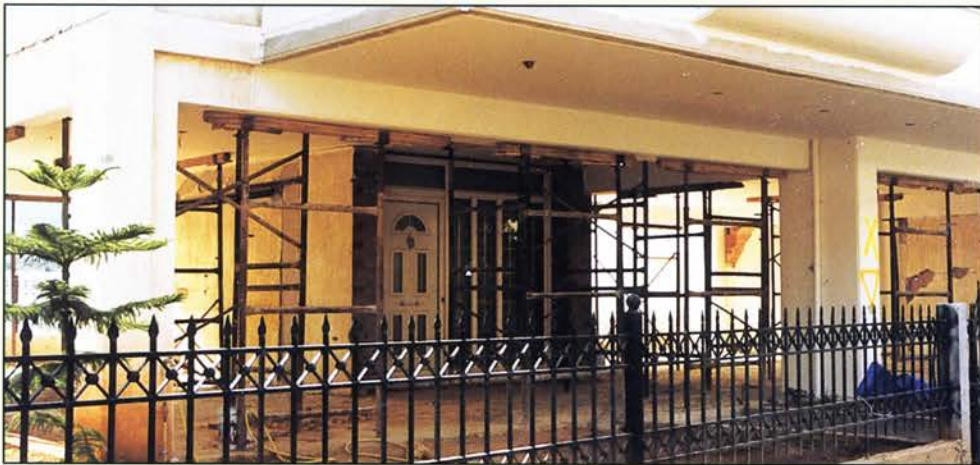
ΑΤΤΙΚΗ - ΑΝΩ ΛΙΟΣΙΑ - 1999 Υποστρώσεις με βιομηχανικά ικριώματα σε διάφορη οικοδομή με Pilotis και ελαφρές ζημιές
