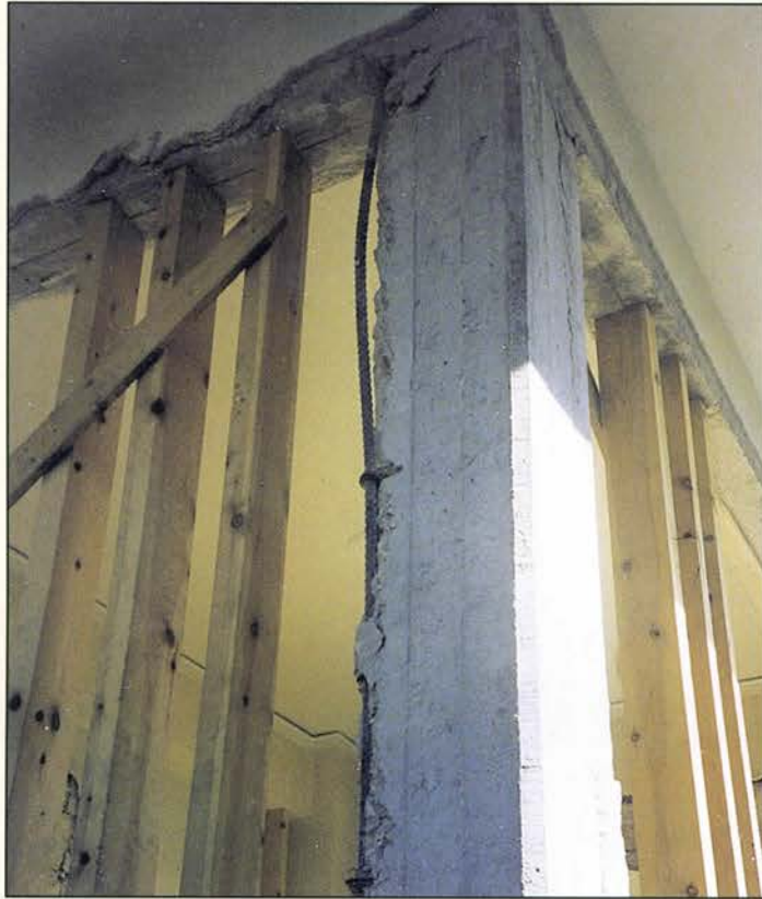
ΑΤΤΙΚΗ - ΑΝΩ ΛΙΟΣΙΑ - 1999 Υποστρώσεις με βιομηχανική ξυλεία στα πλαίσια μεταξύ υποστυλωμάτων
