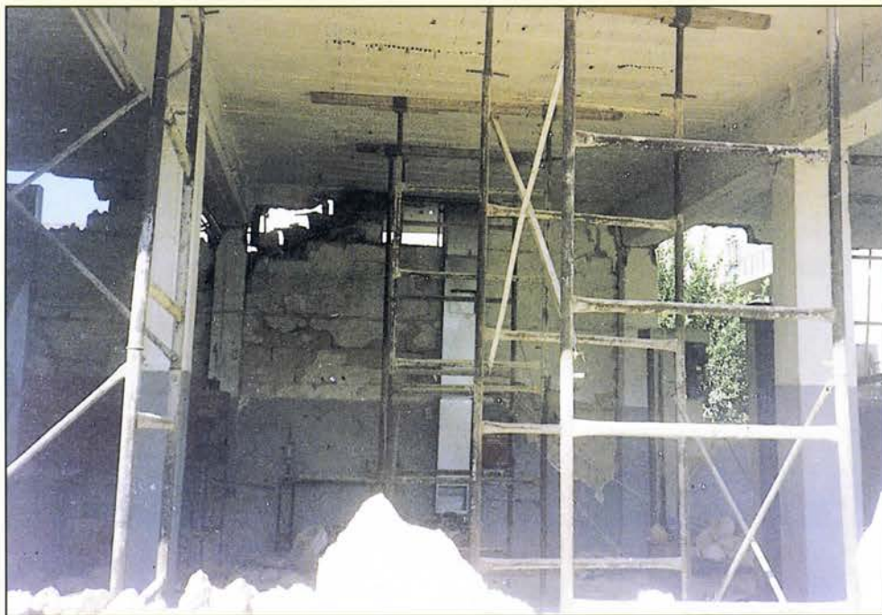
ΑΤΤΙΚΗ - ΜΕΝΙΔΙ- 1999 Μερική υποστήλωση με μεταλλικά βιομηχανικά ικριώματα σε μαλακό όροφο με ελαφρές βλάβες.
