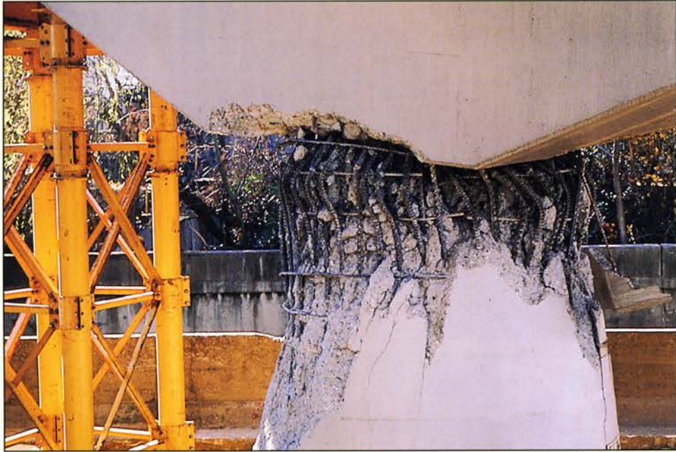
ΚΟΜΠΕ Ιαπωνίας 1995 Εκτεταμένες και βαρείες υποσιλώσεις με «πάσης φύσεως» σιδηρές διατομές, βαρέως τύπου σε μεγάλες γέφυρες της πόλης, που υπέστησαν σοβαρές βλάβες στα βάθρα τους και σε μήκος πολλών χιλιομέτρων.
