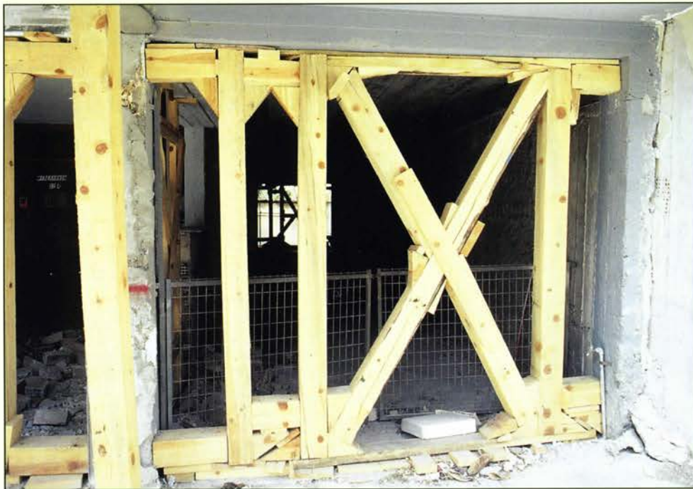
ΚΑΛΑΜΑΤΑ 1986 Υποστηλώσεις - Αντιστηρίξεις με Βιομηχανική Ξυλεία.
