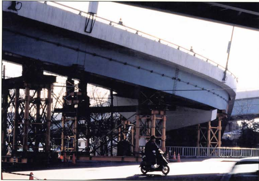
ΚΟΜΠΕ Ιαπωνίας 1995 Εκτεταμένες και βαρείες υποστυλώσεις με «πάσης φύσεως», σιδηρές διατομές, βαρέως τύπου, σε μεγάλες γέφυρες της πόλης, που υπέστησαν σοβαρές βλάβες στα βάθρα και στα ανοίγματά τους.
