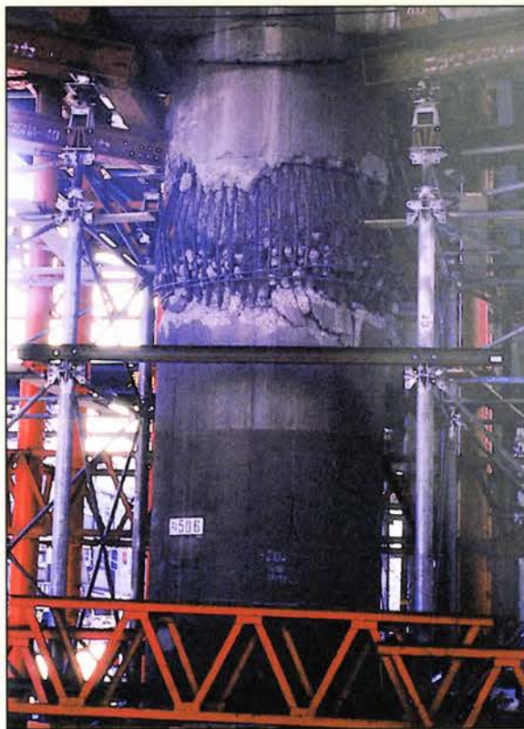
ΚΟΜΠΕ Ιαπωνίας 1995 Εκτεταμένες και βαρείες υποσιλώσεις με «πάσης φύσεως» σιδηρές διατομές, βαρέως τύπου σε μεγάλες γέφυρες της πόλης, που υπέστησαν σοβαρές βλάβες στα βάθρα τους και σε μήκος πολλών χιλιομέτρων.
