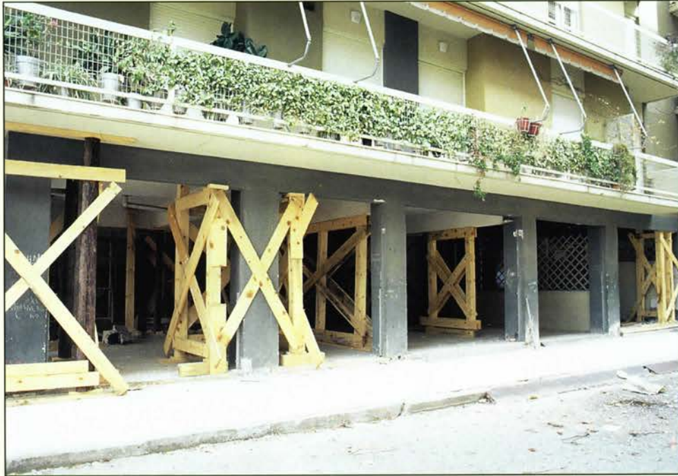
ΚΑΛΑΜΑΤΑ 1986 Υποστηλώσεις - Αντιστηρίξεις με Βιομηχανική Ξυλεία.
