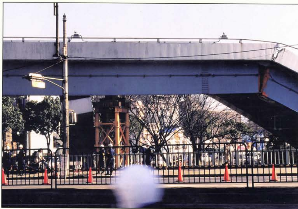
ΚΟΜΠΕ Ιαπωνίας 1995 Εκτεταμένες και βαρείες υποστυλώσεις με «πάσης φύσεως», σιδηρές διατομές, βαρέως τύπου, σε μεγάλες γέφυρες της πόλης, που υπέστησαν σοβαρές βλάβες στα βάθρα και στα ανοίγματά τους.
