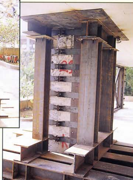
ΜΕΤΑΜΟΡΦΩΣΗ ΑΤΤΙΚΗΣ 1995 Εκτεταμένη υποστήλωση με σιδηρές διατομές (γωνιακά ισχυρά, διπλά ταύ, λάμες, χιαστί συνδέσμους κ.λπ.) σε τετραόροφη οικοδομή με σοβαρές βλάβες στα υποστυλώματα της Pilotis
