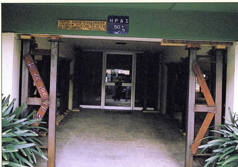
ΑΤΤΙΚΗ - ΝΕΟ ΗΡΑΚΛΕΙΟ - 1999 Εκτεταμένη υποστυλώση με κοιλοδοκούς σε Pilotis εξαώροφης οικοδομής, με σοβαρές βλάβες σε αρκετά από τα υποστυλώματά της
