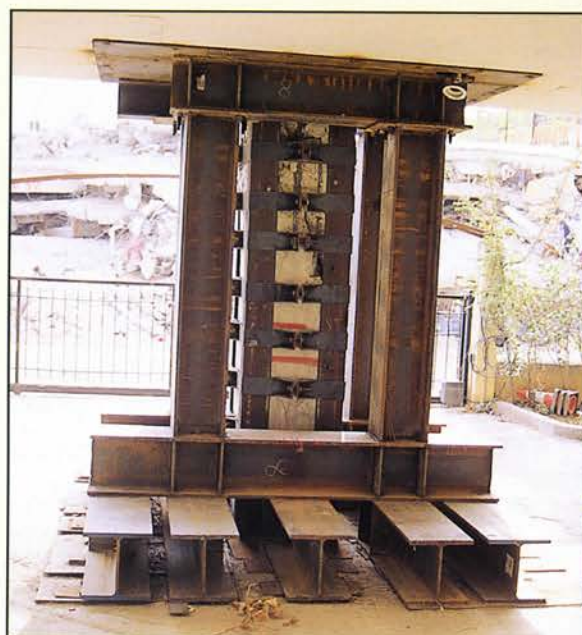
ΜΕΤΑΜΟΡΦΩΣΗ ΑΤΤΙΚΗΣ 1995 Εκτεταμένη υποστήλωση με σιδηρές διατομές (γωνιακά ισχυρά, διπλά ταύ, λάμες, χιαστί συνδέσμους κ.λπ.) σε τετραόροφη οικοδομή με σοβαρές βλάβες στα υποστυλώματα της Pilotis
