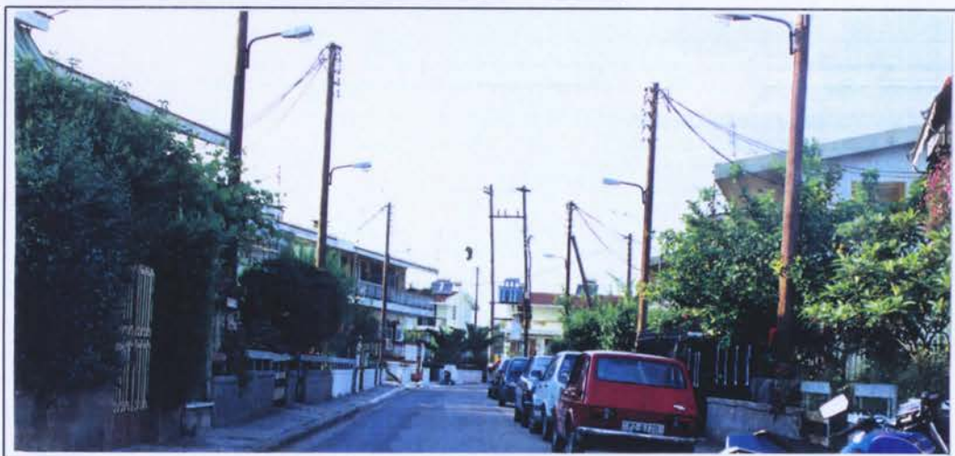
Εικ. 5.3 Αποψη των εργατικών κατοικιών στα βορειοδυτικά όρια της πόλης του Πύργου, όπου εμφανίζονται Αλλουβιακοί σχηματισμοί με παρουσία υδροφόρου ορίζοντα σε πολύ μικρό βάθος. Παρά τον πανομοιότυπο τρόπο κατασκευής, ορισμένες κατοικίες υπέστησαν σοβαρές βλάβες από τοπικά φαινόμενα διαφορικών καθιζήσεων, ενώ άλλες παρέμειναν ανέπαφες.
