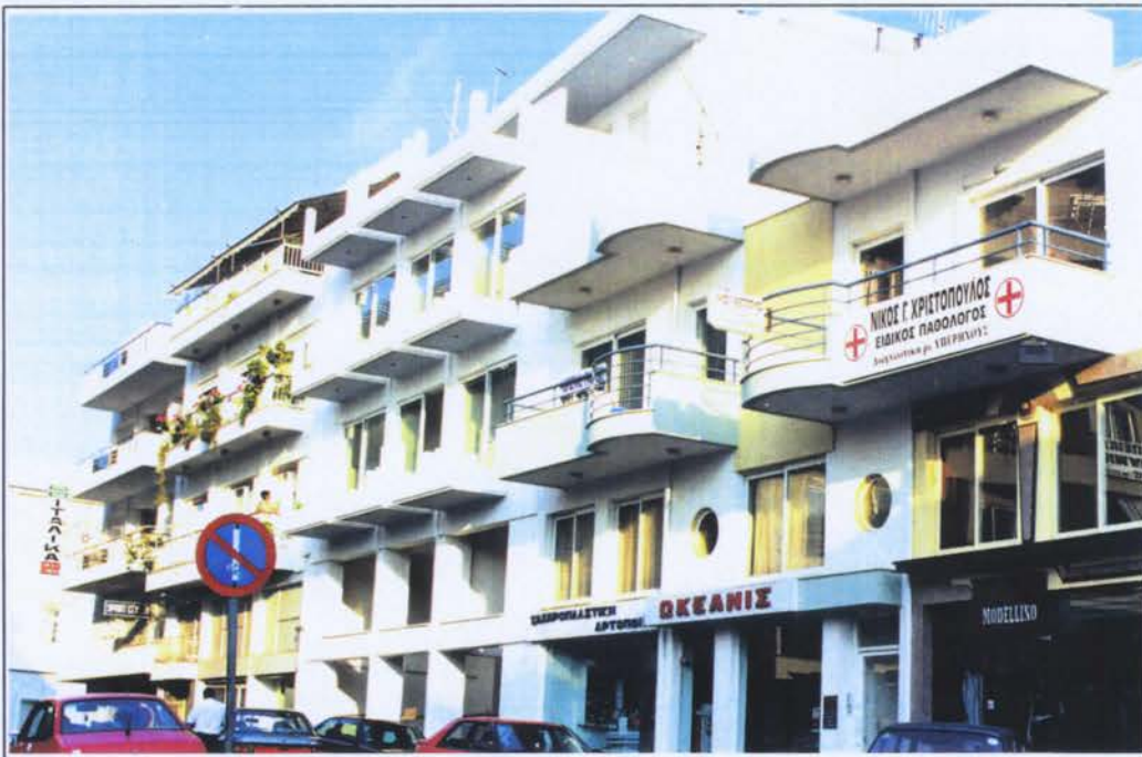
Εικ. 6.6 Η οδός Λεπτινών, στην οποία αναπτύσσονται μεικτές χρήσεις εμπορίου, υπηρεσιών αλλά και κατοικίας.
