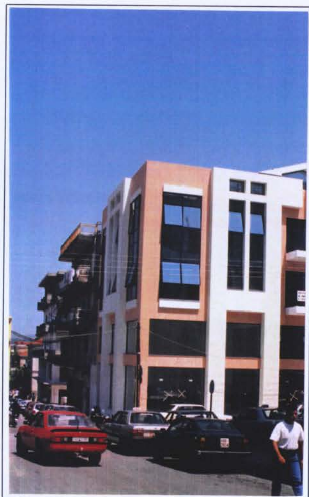
Εικ. 6.16 Σύγχρονες κατασκευές με ειδική αντισεισμική σχεδίαση που έχουν ανεγερθεί μετά το σεισμό του 1993 (Αγίου Γεωργίου και Θεμιστοκλέους - Μεγάλου Αλεξάνδρου).
