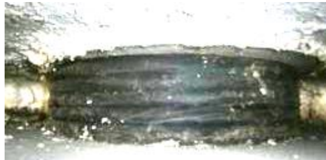
Σημαντικές πλευρικές παραμορφώσεις στρώσεων ελαστομερούς εφεδράνου
