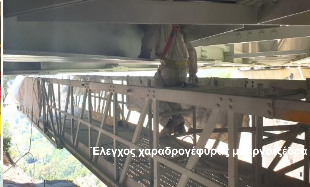
Έλεγχος με καλάθι και αναρτημένο φορτίο
