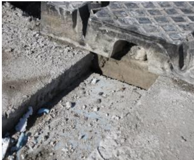
Ανεπαρκής γεφύρωση διακένου γέφυρας - ακροβάθρου
