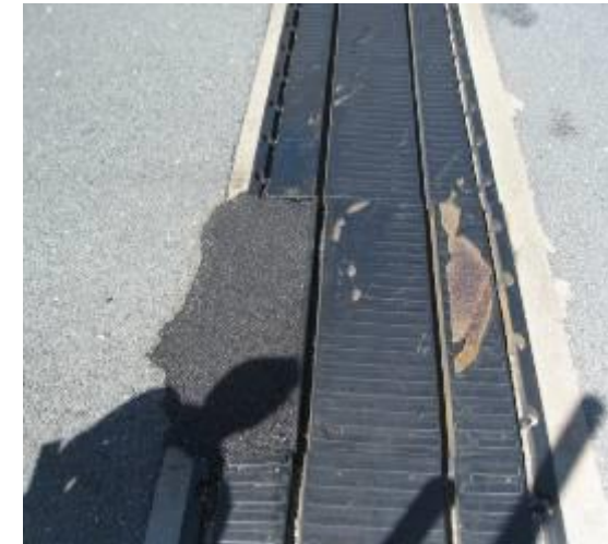
Αστοχίες τμήματος αρμοκαλύματος
