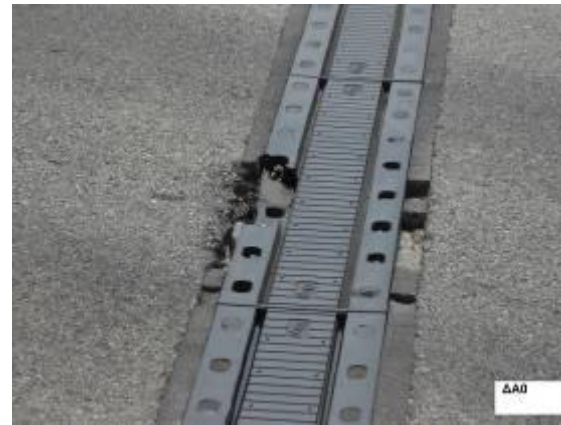
Ανεπαρκής γεφύρωση διακένου γέφυρας - ακροβάθρου
