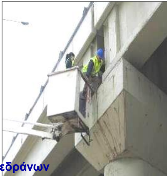
Έλεγχος σκυροδέματος σε ποταμογέφυρα
