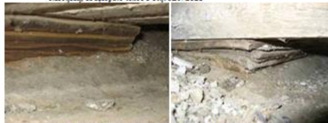
Εξ. 10.16: Ασταχία ελαστομεταλλικά κεντρικών Γεφυρών Αξιά ΓΕ03.18.19
