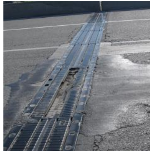
Αστοχίες τμήματος αρμοκαλύματος
