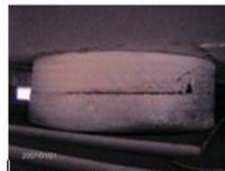
Εξ. 10.17: Εφεδράνο γέφυρας Καρμύνας (αυτοκίμα)
