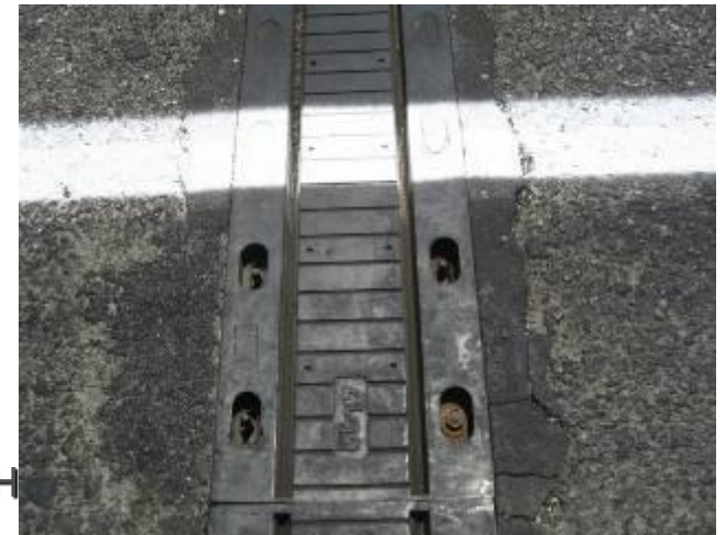
Αστοχίες τμήματος αρμοκαλύματος
