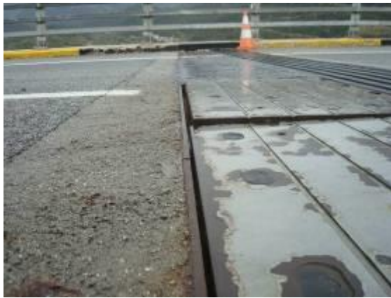
Ανεπαρκής γεφύρωση διακένου γέφυρας - ακροβάθρου
