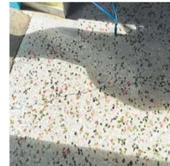
Εκτενείς ρωγμές στο δάπεδο λόγω πιθανής καθίζησης του εδάφους
