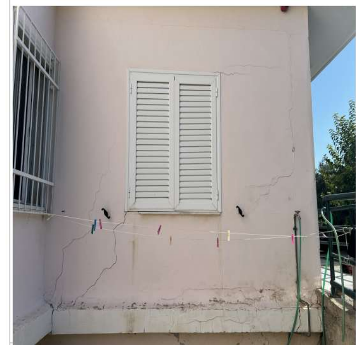
Ρηγματώσεις θλιβόμενης διαγωνίου
