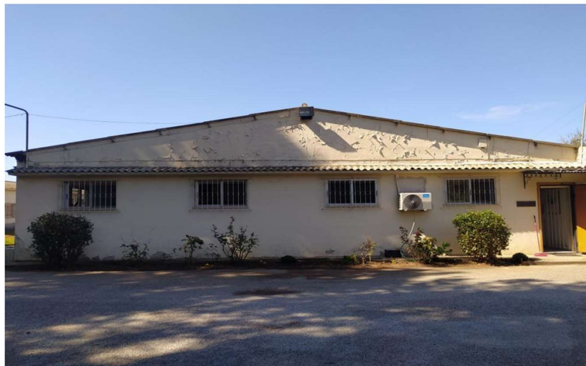
Φωτο 1: ανατολική όψη με την είσοδο των γραφείων του κτιρίου
