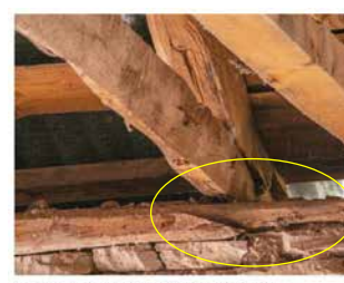
Εκ. 79: Λεπτομέρεια συνδέσεως ψαλιδιού με οριζόντια δοκό
