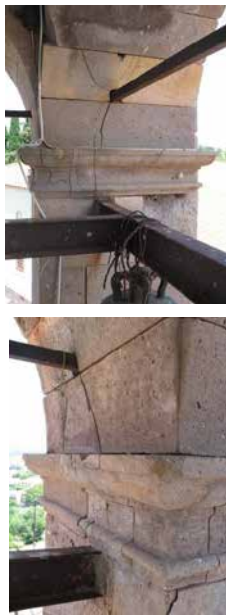
Λεπτομέρεια διασταύρωσης των ελεγκτήρων των σταθμών 3', 3'' και 3'''
