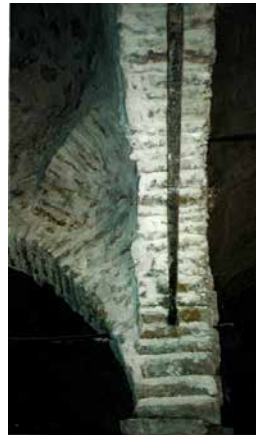
Λεπτομέρεια διασταύρωσης των ελεγκτήρων των σταθμών 3', 3'' και 3'''
