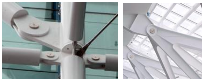
ΣΧΗΜΑ Δ5/4Θ-6. Παραδείγματα αρθρωτών συνδέσεων μέσω πείρων.
