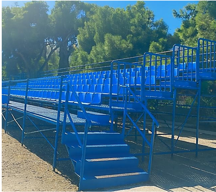
ΕΙΚΟΝΑ Δ1/2-2. Αυτοτελής κερκίδα από μεταλλικά στοιχεία.
