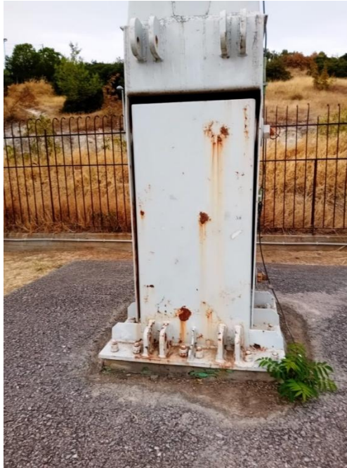
ΕΙΚΟΝΑ Δ3/3-4. Σταθερά εδραζόμενος πυλώνας επί του εδάφους. Ο πυλώνας εξετάζεται.
