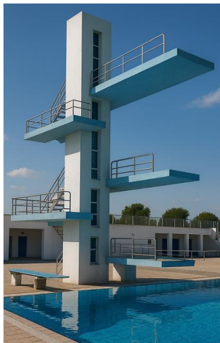
ΕΙΚΟΝΑ Δ3/3-3. Πλατφόρμα κατάδυσης από σπλισμένο σκυρόδεμα.
