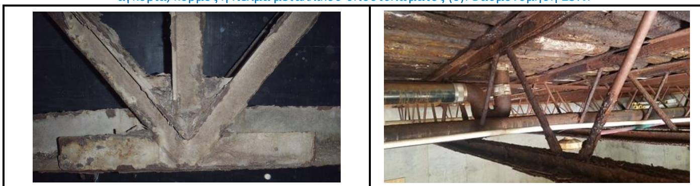
ΕΙΚΟΝΑ Δ4-16. Διάβρωση σύνδεσης μεταλλικού δικτυώματος και μεταλλικού δικτυώματος μεταλλικών κτηρίων. Βαθμονόμηση 50%.
