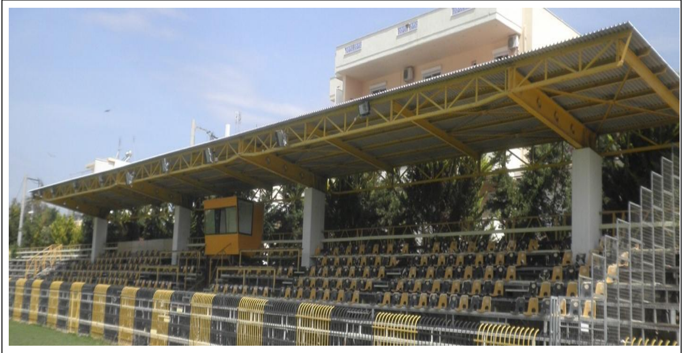
ΕΙΚΟΝΑ Δ2/4γ-1. Μεταλλική επιστέγαση με οριζόντιες δοκούς εν προβάλω.
