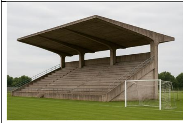
ΣΧΗΜΑ Δ2/4γ-1. Έλεγχος κριτηρίου «μεγάλο άνοιγμα οιονεί οριζοντίων στοιχείων».
