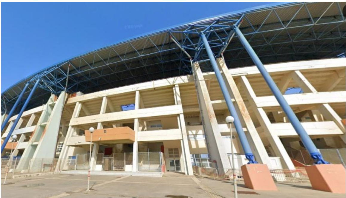
ΕΙΚΟΝΑ Δ2/3-1. Αυτοτελές στέγαστρο, χωρίς σύνδεση με την κερκίδα. Δεν εξετάζεται η αλληλεπίδραση.
