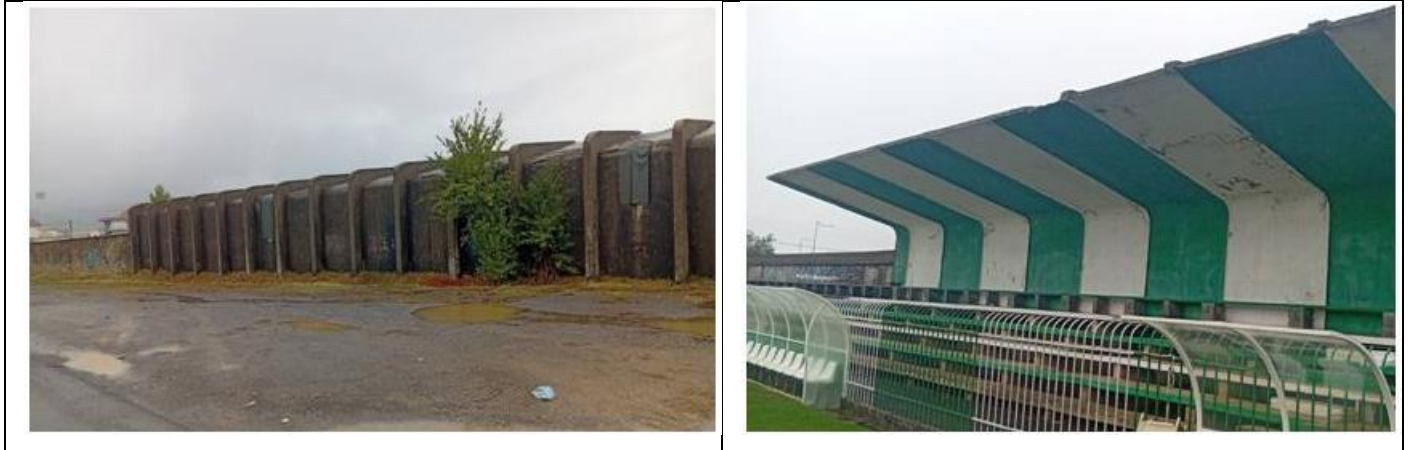
ΕΙΚΟΝΑ Δ2/4γ-1. Στέγαστρο οπλισμένου σκυροδέματος
