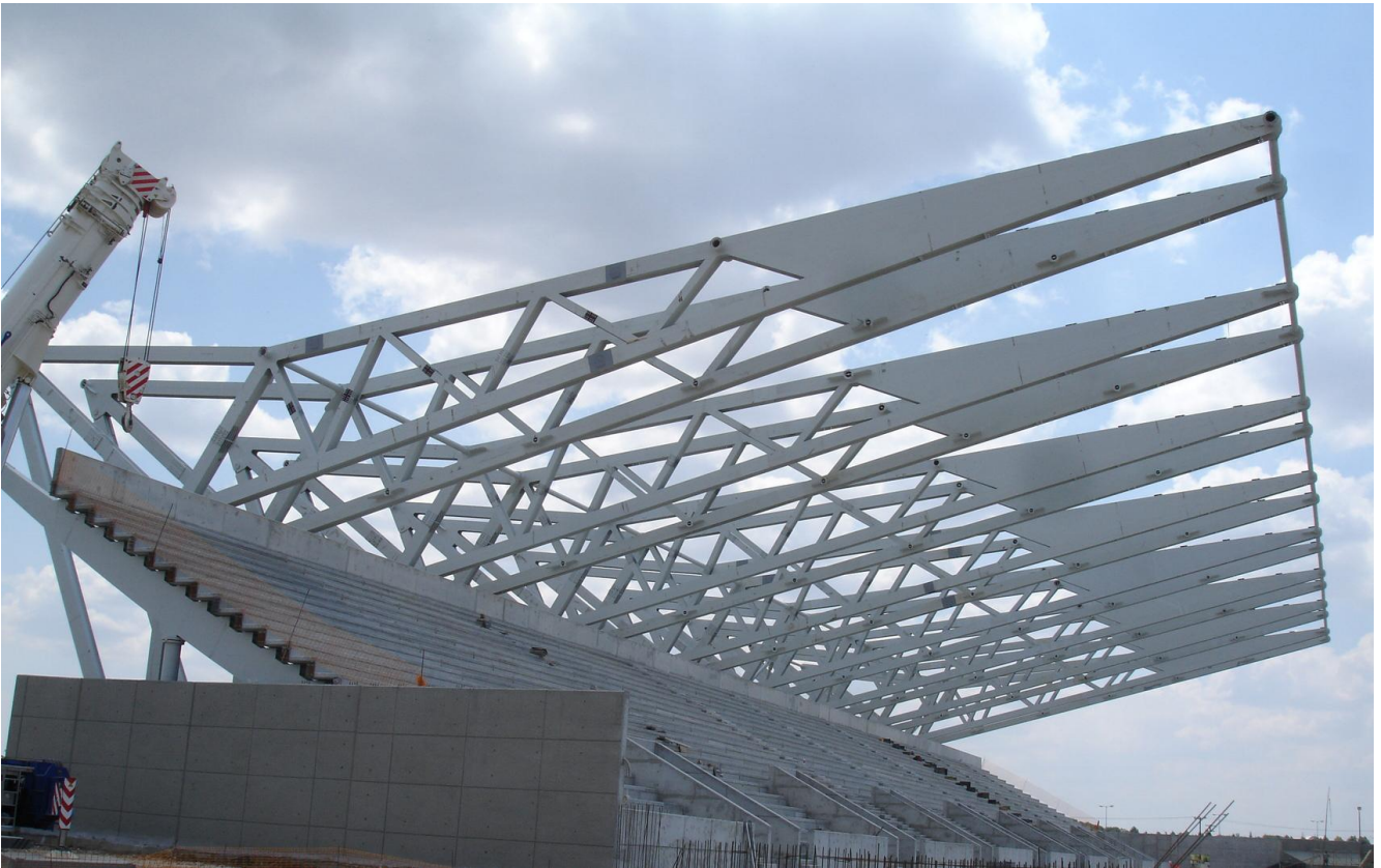
ΕΙΚΟΝΑ Δ2/4γ-2. Μεταλλικό στέγαστρο με οριζόντιες εν προβόλω δικτυωτές δοκούς μεταβλητού ύψους
