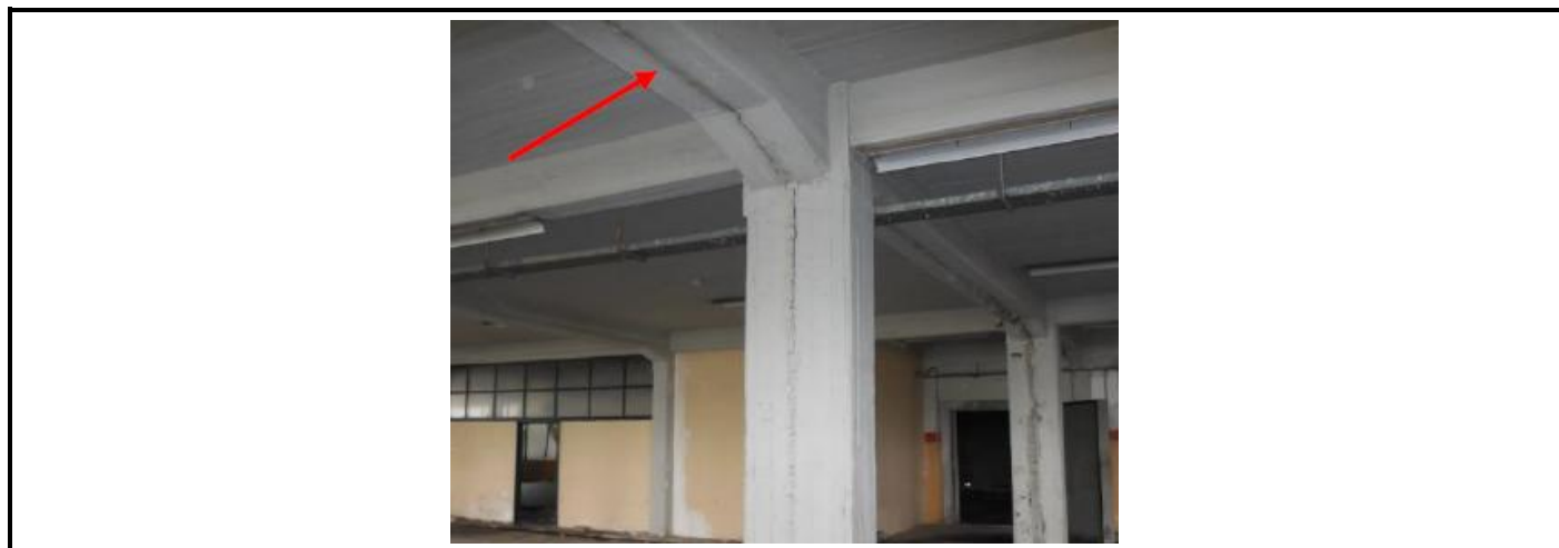
ΕΙΚΟΝΑ Δ4-21. Αρμός μεταξύ στατικά ανεξάρτητων τμημάτων κτιρίου και όχι βλάβη στο υποστυλωμα.
