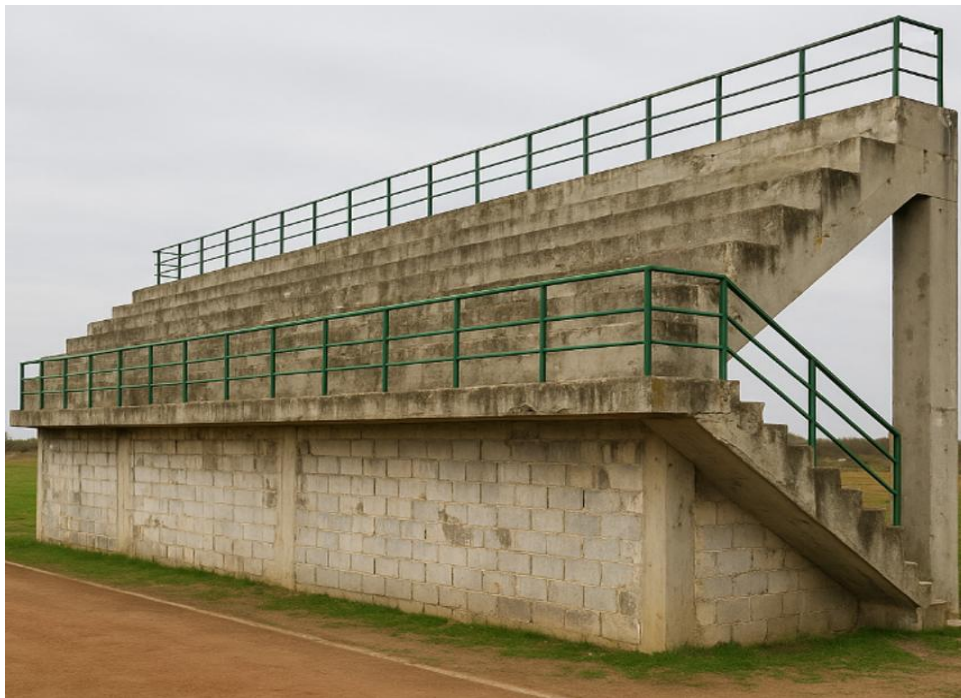
ΕΙΚΟΝΑ Δ1/2-1. Αυτοτελής κερκίδα από οπλισμένο σκυρόδεμα.
