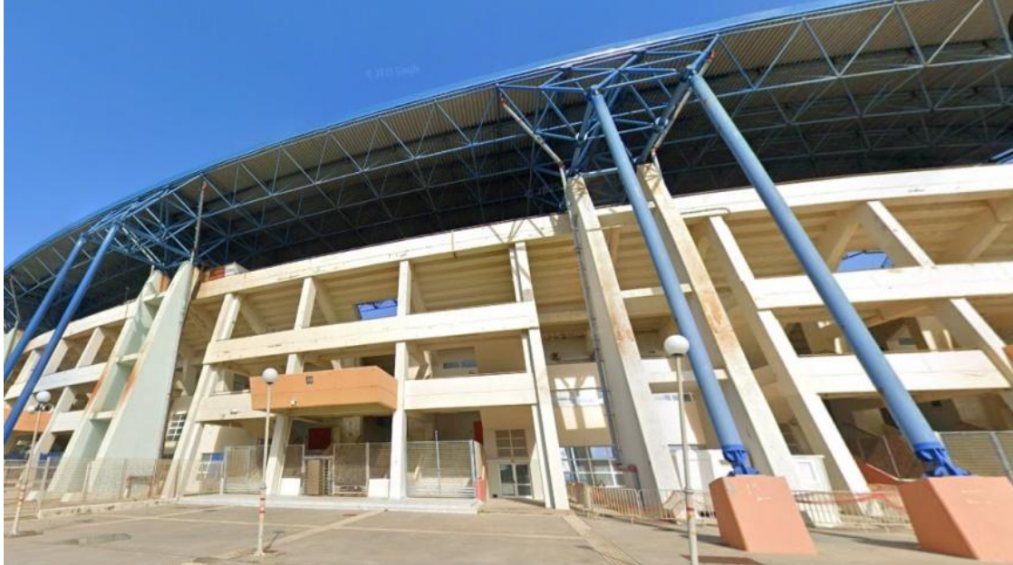
ΕΙΚΟΝΑ Δ1/3-1. Αυτοτελές στέγαστρο, χωρίς σύνδεση με την κερκίδα. Δεν εξετάζεται η αλληλεπίδραση.
