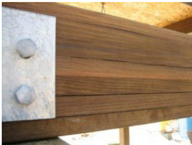
ΕΙΚΟΝΑ Α-3. Εμφάνιση ρωγμών σε επικολλητή ξυλεία.
