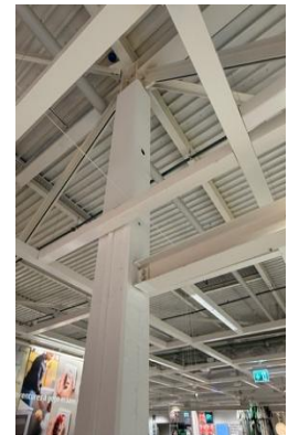
ΣΧΗΜΑ Δ2/4ζ-3. Δέσμευση στροφής κεφαλής υποστυλώματος λόγω σύνδεσής του με δικτυωτό ζύγωμα.
