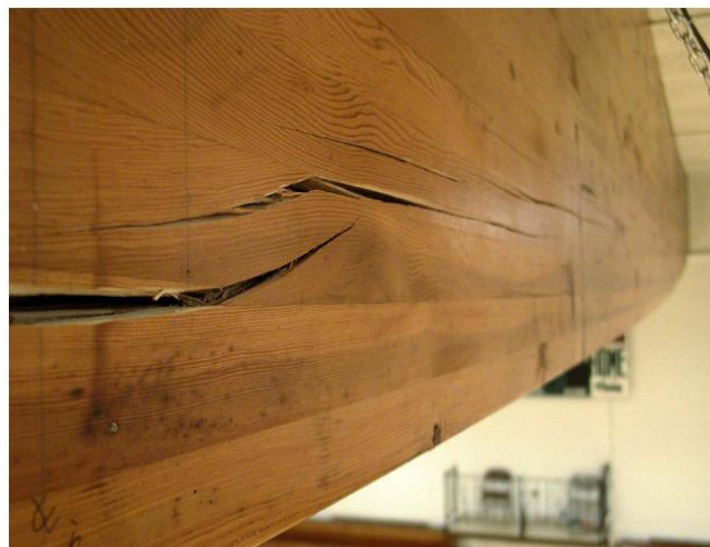
ΕΙΚΟΝΑ Α-3. Εμφάνιση ρωγμών σε επικολλητή ξυλεία.
