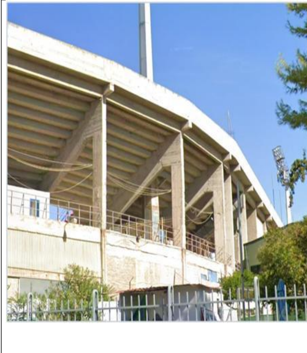
ΣΧΗΜΑ Δ3/5στ-1. Έλεγχος κριτηρίου «κίνδυνος κρούσης με γειτονικά δομήματα».
