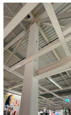
ΣΧΗΜΑ Δ5/40-3. Δέσμευση στροφής κεφαλής υποστυλώματος λόγω σύνδεσής του με δικτυωτό ζύγμα.
