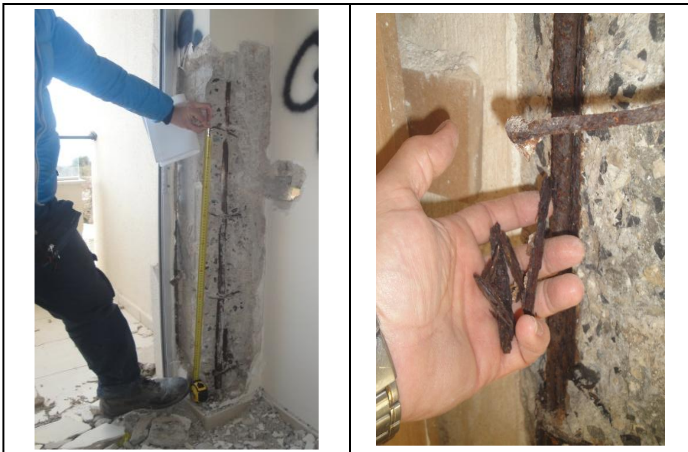
ΕΙΚΟΝΑ Δ4–12. (α) Περιορισμένη οξείδωση, εύκολη απομάκρυνση ρηγματωμένης επικάλυψης, βαθμονόμηση 25%. (β) Έντονη διάβρωση, απομείωση διατομής μεταξύ 20% και 40% σε δύο γειτονικούς στύλους, βαθμονόμηση 75%.
