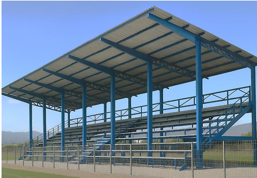
ΕΙΚΟΝΑ Δ2/3-2. Κοινός φέρων οργανισμός κερκίδας και στεγάστρου. Εξετάζεται η επίδραση της κερκίδας επί του στεγάστρου.
