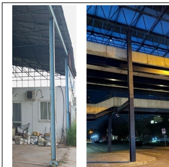
ΣΧΗΜΑ Δ5/4β-4. Λυγηρά μεταλλικά υποστυλώματα χωρίς επαρκή αριθμό πλευρικών εξασφαλίσεων.
