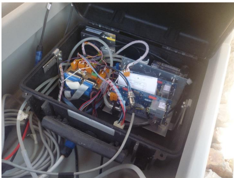
Εικόνα 2 Εργασίες εγκατάστασης σταθμού μέτρησης ροής CO 2 (Νέα Καμένη)
