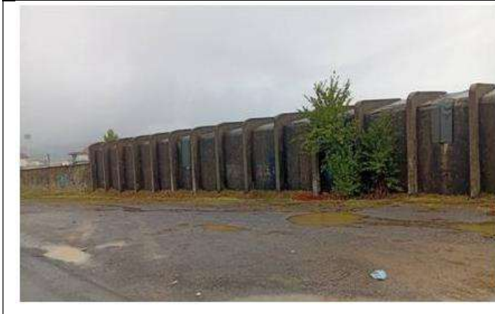
ΕΙΚΟΝΑ Δ2/4γ-1. Στέγαστρο οπλισμένου σκυροδέματος
